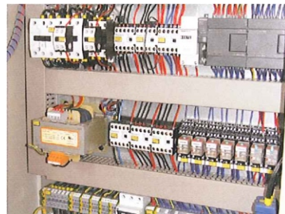
Schaltschrank / SPS-Steuerung
